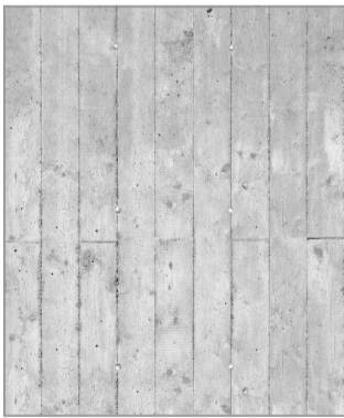
DETAIL STRUKTURY POHLEDOVÉHO BETONU ŠACHTY VÝTAHU
